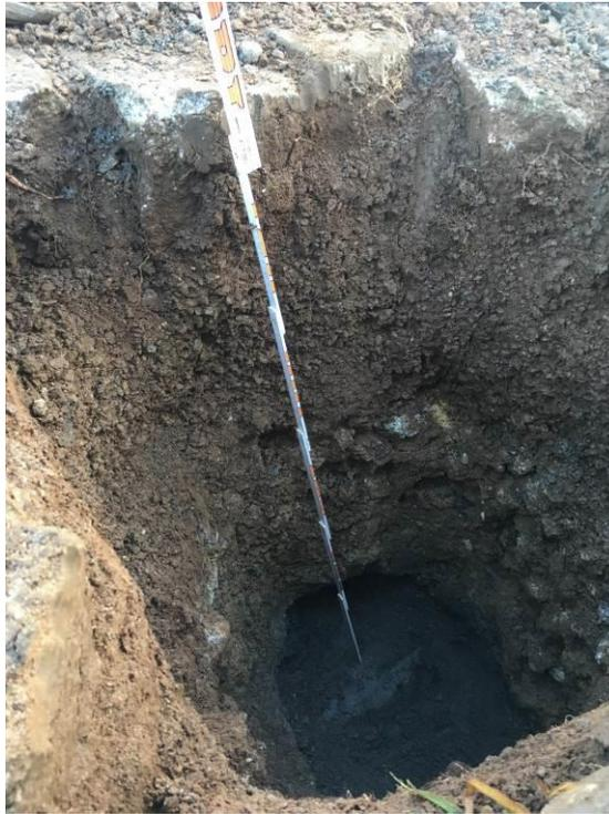
Bild 5: Haslach im Kinzigtal, Schnapperwehr, Auffinden der oberen Ummantelung der Gasleitung in einer einer Tiefe von 1,02 m u. GOK (219,96 m ü. NN).
