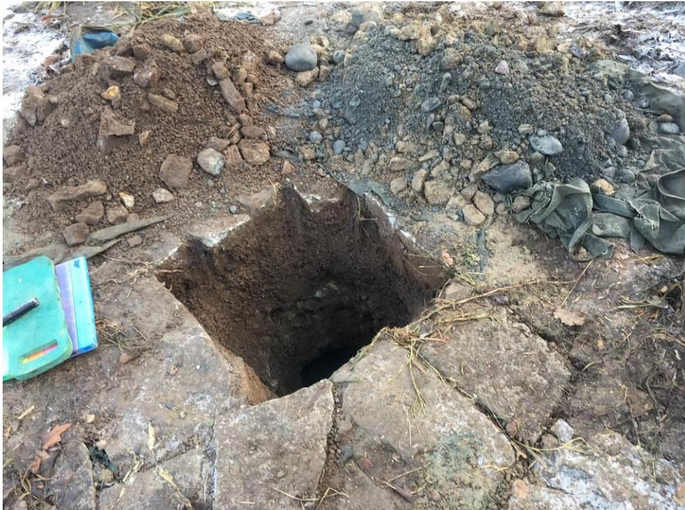
Bild 7: Haslach im Kinzigtal, Schnapperwehr, Schurf auf der Gasleitung.
