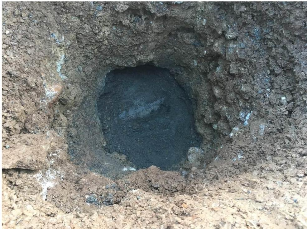
Bild 6: Haslach im Kinzigtal, Schnapperwehr, Auffinden der oberen Ummantelung der Gasleitung in einer Tiefe von 1,02 m u. GOK (219,96 m ü. NN).
