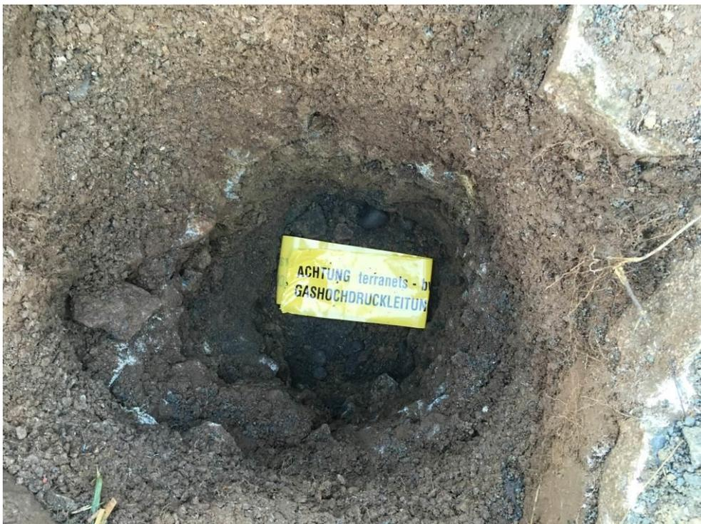
Bild 8: Haslach im Kinzigtal, Schnapperwehr, Verschuß des Schurfes und Einbringen eines Warnhinweises.
