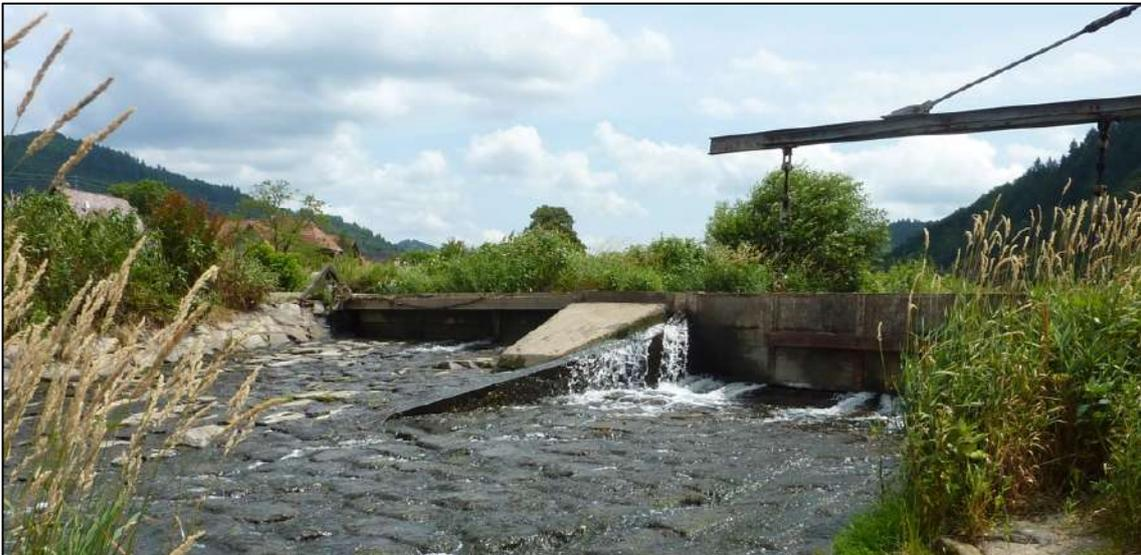
**Abb. 2-5:       Detailansicht fester Wehrabschnitt und beweglicher Schnapper - Blick gen Oberwasser (Quelle: HE Roth)**
