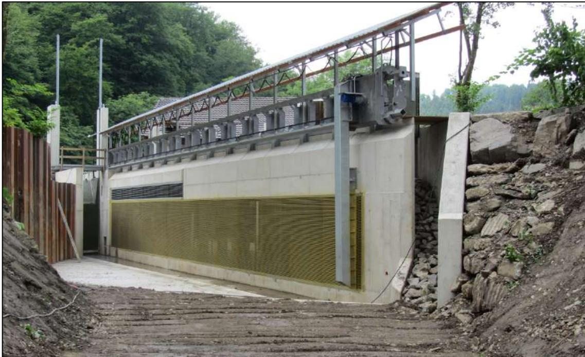
**Abb. 3-3: Beispiel Horizontalrechen vor Inbetriebnahme ( $d_R = 12 \text{ mm}$ ,  $Q_A = 14 \text{ m}^3/\text{s}$ ) (Quelle: IBFM)**
