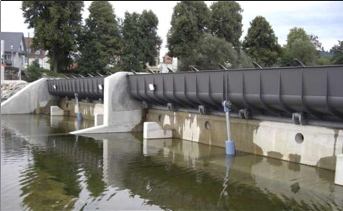
**Abb. 3-8: Baugleich ausgeführte Wehrklappen der WKA Gengenbach / Kinzig - Betriebszustand (Quelle: HE Roth)**
