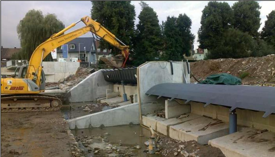
**Abb. 3-7: Baugleich ausgeführte Wehrklappen der WKA Gengenbach / Kinzig – Bauzustand (Quelle: HE Roth)**
