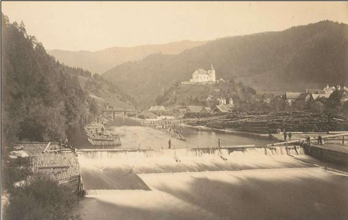
**Abb. 3-10:** historische Abbildung - in Wehrkörper integrierte Floßgasse (Quelle: unbekannt)
